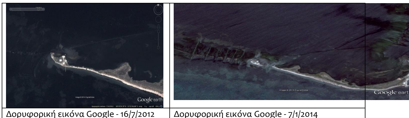
Εικόνα 6-6 Διάβρωση στην αμμονησίδα στο ιχθυοτροφείο Κόμμα
